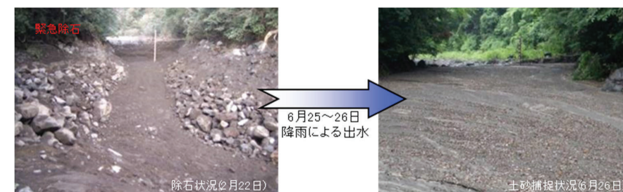
高千穂川における緊急対策(除石)と流出土砂の捕捉状況(高原町)
